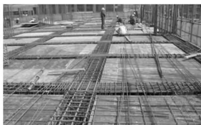
图3 梁的施工
