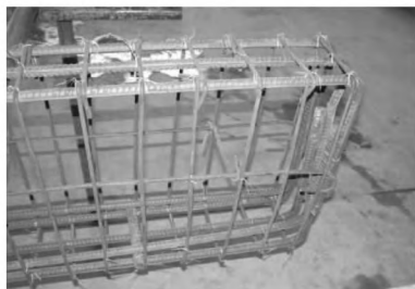
图5 梁的钢筋绑扎
